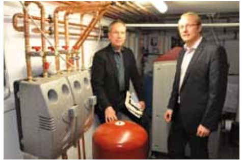
Florian Hartke (rechts) von der ZVO Energie GmbH erläutert Pastor Heling die neue Heizungsanlage. Foto: Döbler
